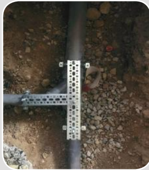
■ مهار سوپردرین در کف با روشی خلاقانه با استفاده از سوپرفیکس تخت
