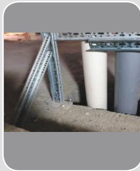
■ اجرای خلاقانه ساپورت لوله های عمودی
