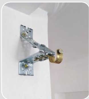
■ نصب پایه پرده
