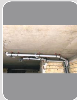
■ ساپورت لوله های فاضلابی sk و هواکش با سوپرفیکس U در کم ترین ارتفاع از سقف
