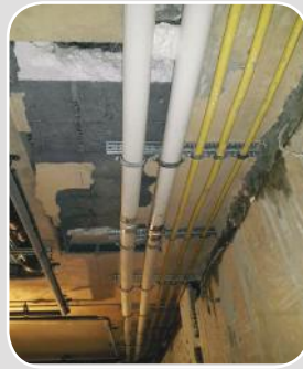
■ مهار همزمان لوله های آبرسانی و سیستم سرمایش
