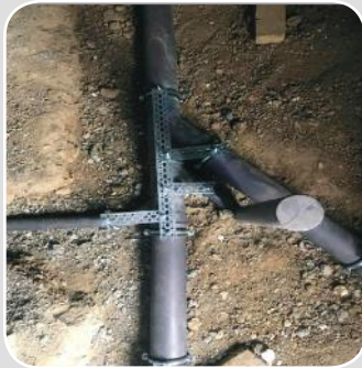
■ مهار سوپردرین در کف با روشی خلاقانه با استفاده از سوپرفیکس تخت
